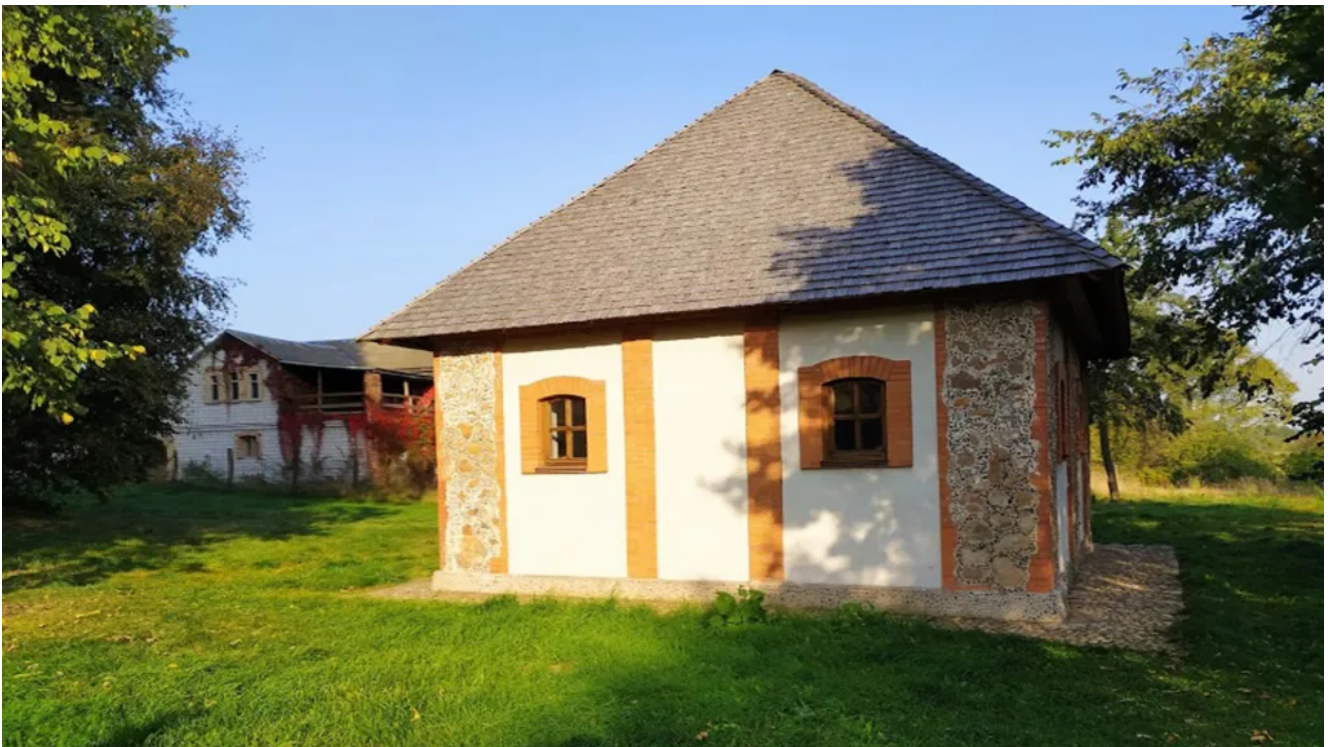
Строительные материалы говорят, что здесь ведутся восстановительные работы усадебного дома и оранжереи.
