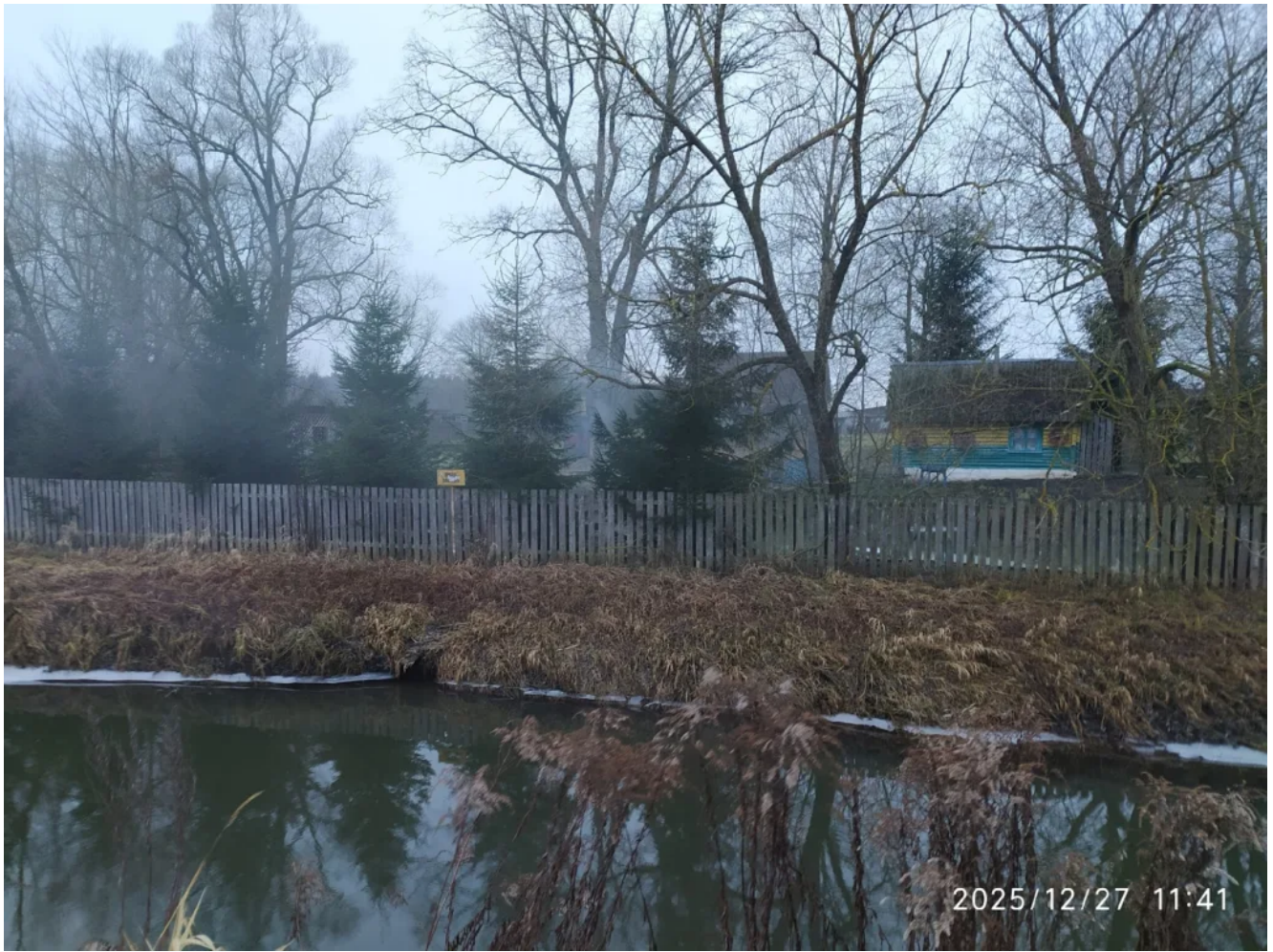
Мост из бревен на 15-м километре дороги.
