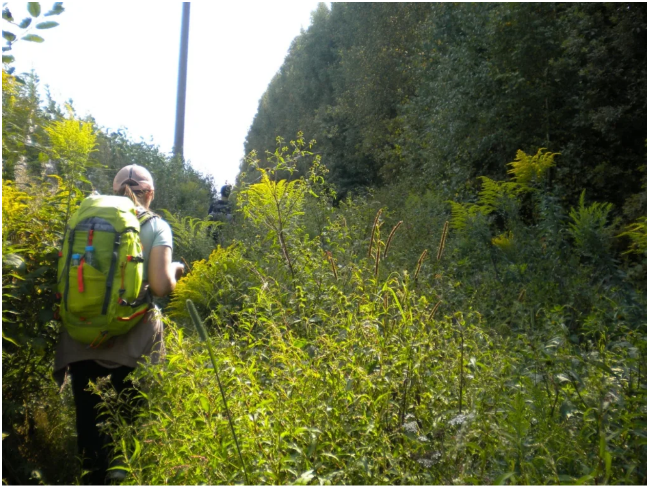
Поросшая ЛЭП со второго километра пути.
