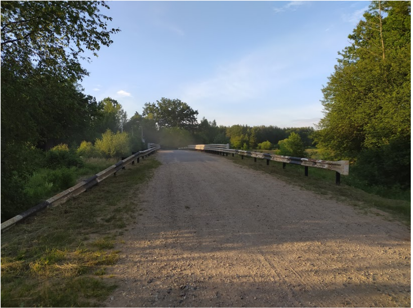
Мост через реку Уша у деревни Шиково
